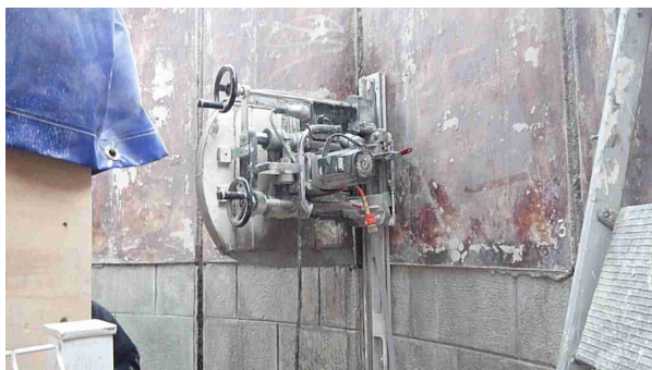
1- découpe effectuée par une machine à eau achetée pour le chantier
