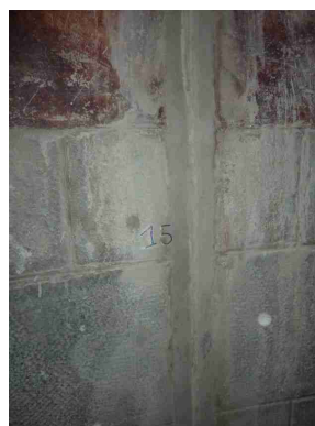
5- montant recalé et rescellé
