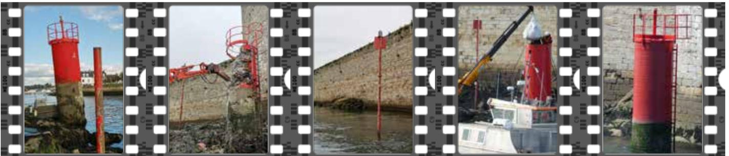
Suite à un abordage, une tourelle située à l'entrée du port de Concarneau est endommagée. Le soubassement de la tourelle est désolidarisé de la roche, en suspension sur ses ancrages. La déconstruction est effectuée et un espar est posé provisoirement. Après acheminement, la DIRM NAMO met en place une nouvelle tourelle.
