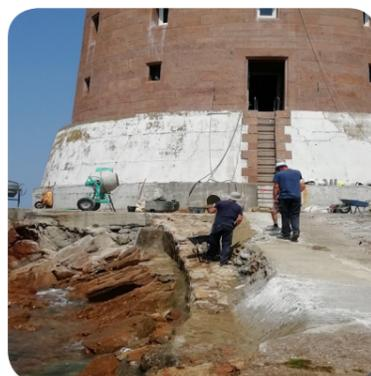
⊙ Réparation de la tourelle An euden en baie de Morlaix. Les travaux ont été effectués grâce à la mise en œuvre d'une pompe à béton depuis le pont du navire de travaux CHARLES
