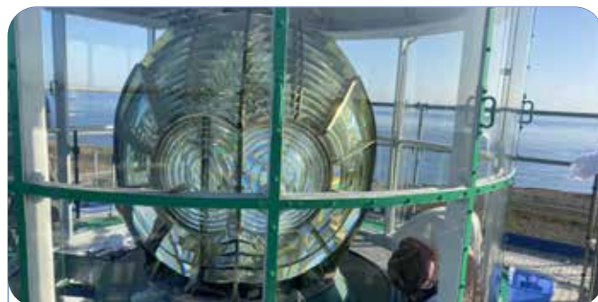
Les agents de la DIRM NAMO de Saint-Malo ont assuré la réfection de la lanterne du phare du Cap Fréhel qui abrite une optique de Fresnel.
