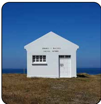
Bâtiment ayant abrité le signal sonore
