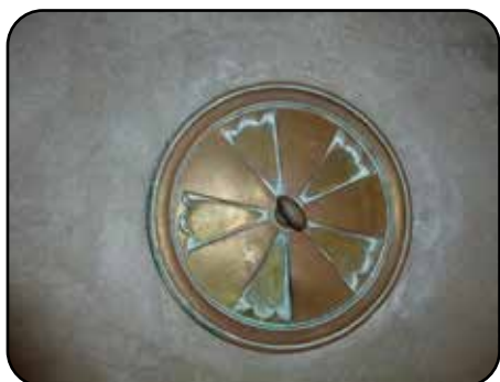
Une aération dans la lanterne
