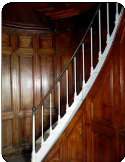
Escalier menant à la lanterne
