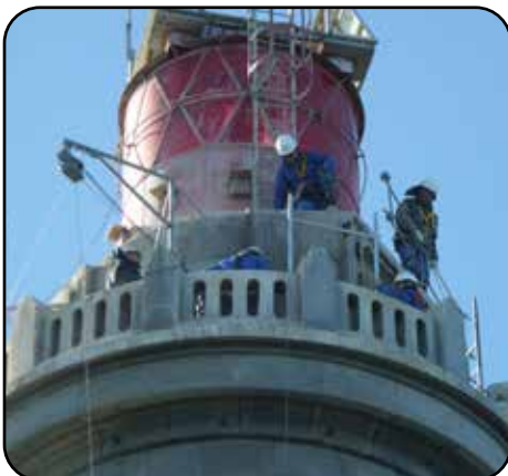
Travaux sur la lanterne
