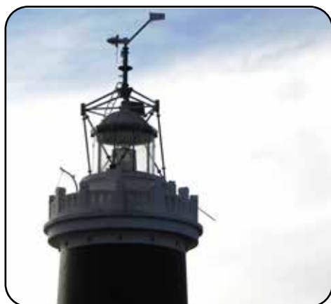
La lanterne et l'aérogénérateur
