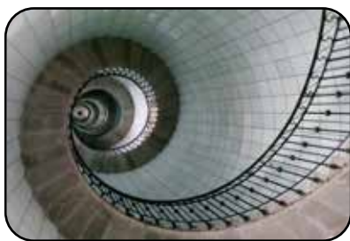
L'escalier recouvert d'opalines
