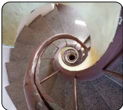
L'escalier d'accès à la lanterne
