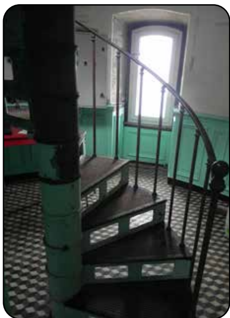
L'escalier d'accès à la lanterne
