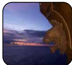
Tête de lion pour l'évacuation de l'eau de pluie
