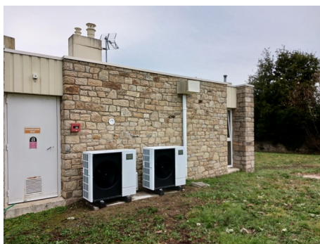
Photo 1 : installation des pompes à chaleur du bâtiment de casernement « foyer »
