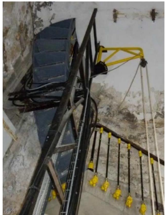
La voûte au sommet du fût et l'escalier d'accès à la chambre de veille
