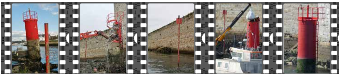
Remplacement d'une tourelle par les services de la DIRM NAMO
