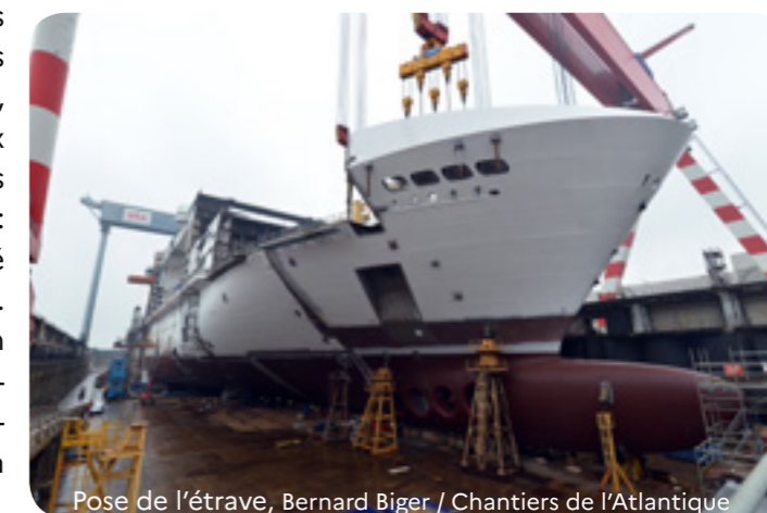
Pose de l'étrave, Bernard Biger / Chantiers de l'Atlantique
