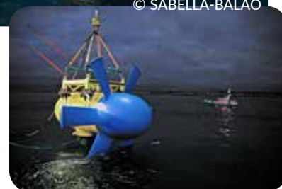
Immersion de l'hydrolienne dans le passage du Froveur © SABELLA-BALAO
